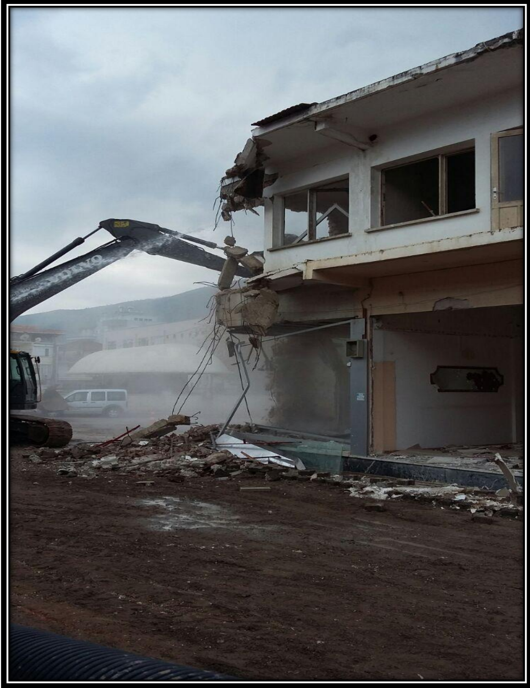
Yıkılacak Derecede Tehlikeli Yapıların Yıkım Fotoğrafları
